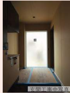
玄関工事中写真
