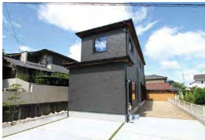
A号地外観
