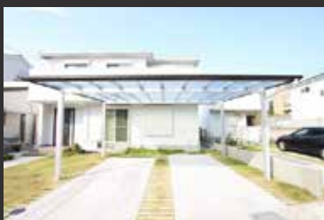
カーポート施工
