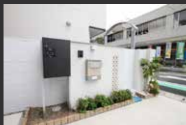
宅配ポスト施工
