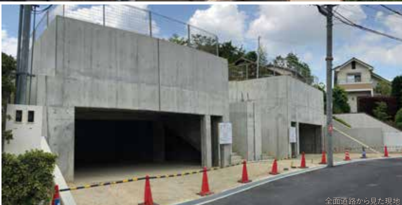
全面道路から見た現地
